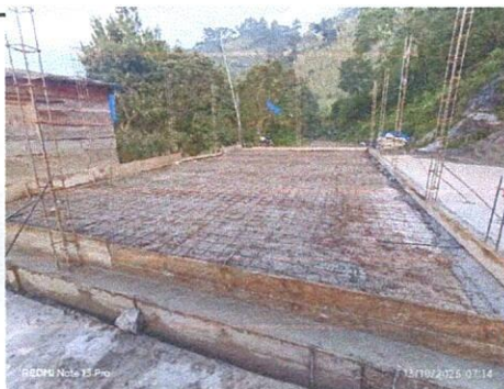
Foto 5: instalación de eletromalla
