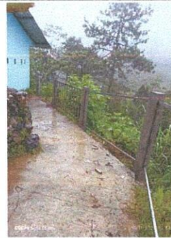
Foto 2: Instalación de barandas
