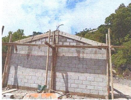
Foto 3: Fundición de soleras
