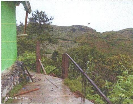
Foto 1: fundición de columnas para la baranda
